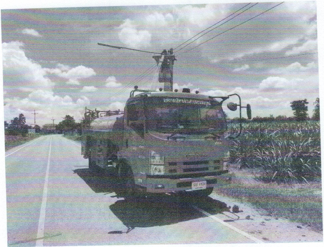
ภาพถ่ายการดำเนิน ซ่อมไฟฟ้าส่องสว่าง หมู่ที่ ๑ บ้านขาม ดำเนินการเรียบร้อย
